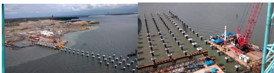
Figura 7 Construcción del Puerto de Aguadulce
