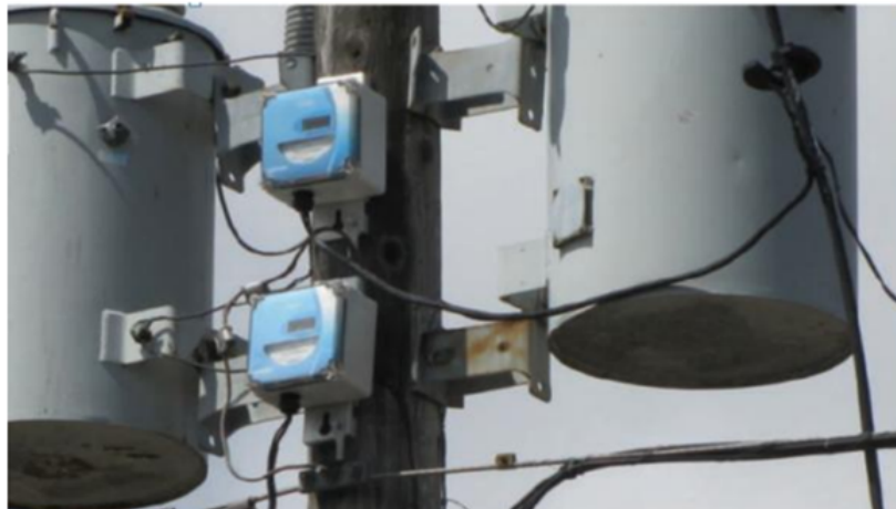
Figura 2.7.2: Monitor de transformadores
