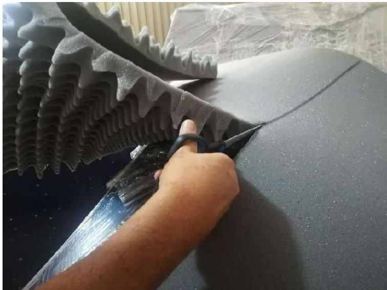
Figura 80. Montaje módulo 2 y 3. Recorte y pegado de espumas.
