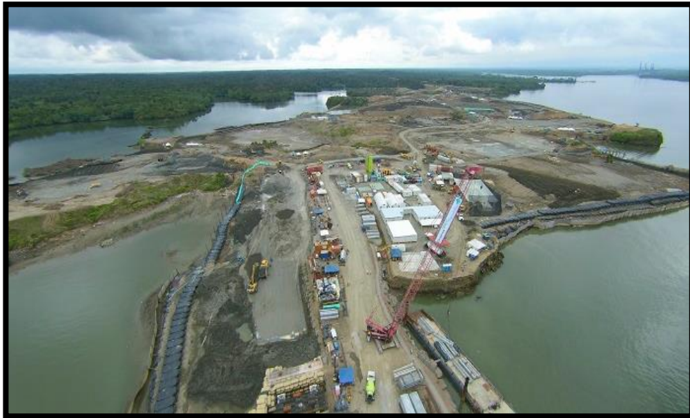
Figura 2. Fotografía de la zona interna de la obra en construcción del Puerto Aguadulce
