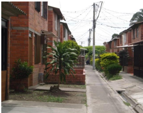
Fotografía 23. Barrio Ciudadela Comfaunión que goza de andenes en buen estado.
