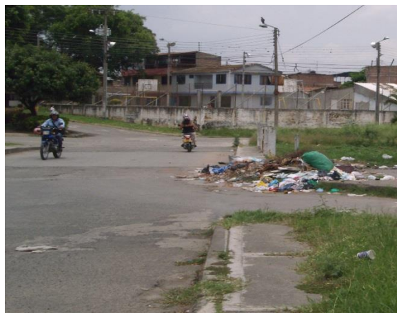
Fotografía 37. Los andenes se encuentran “invadidos” por el pasto, además se observan desechos sólidos o escombros que contaminan ambiental y visualmente y que impiden el libre tránsito del peatón
