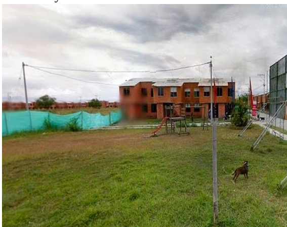
Fotografía 24. Parque infantil de la Urb. Palma real deteriorado. Se ha convertido en lugar donde mascotas hacen sus necesidades.
