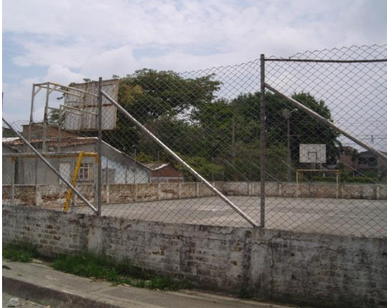
Fotografía 51. La Zona Deportiva del barrio Juan Pablo II (estrato 2 y 3) se encuentra encerrado con malla y está en un estado aceptable.
