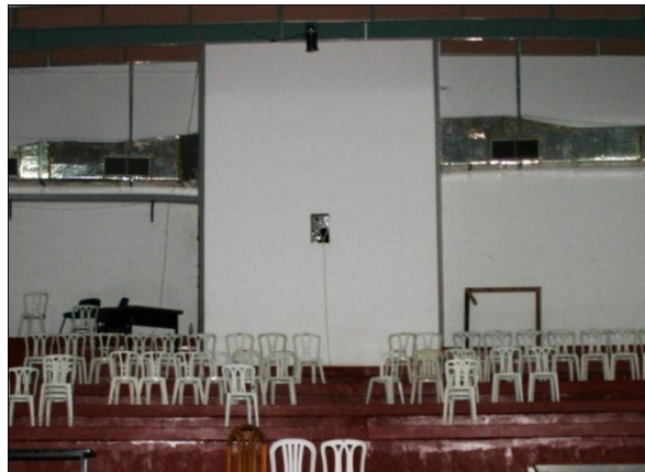
Parte trasera del auditorio, donde se ubica el aire acondicionado y el cuarto para almacenar los equipos de sonido.
