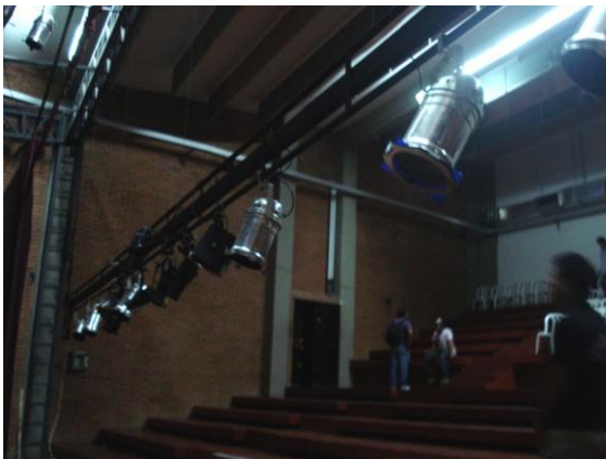
El sistema de poleas permite el descenso de las luces para su mantenimiento.
