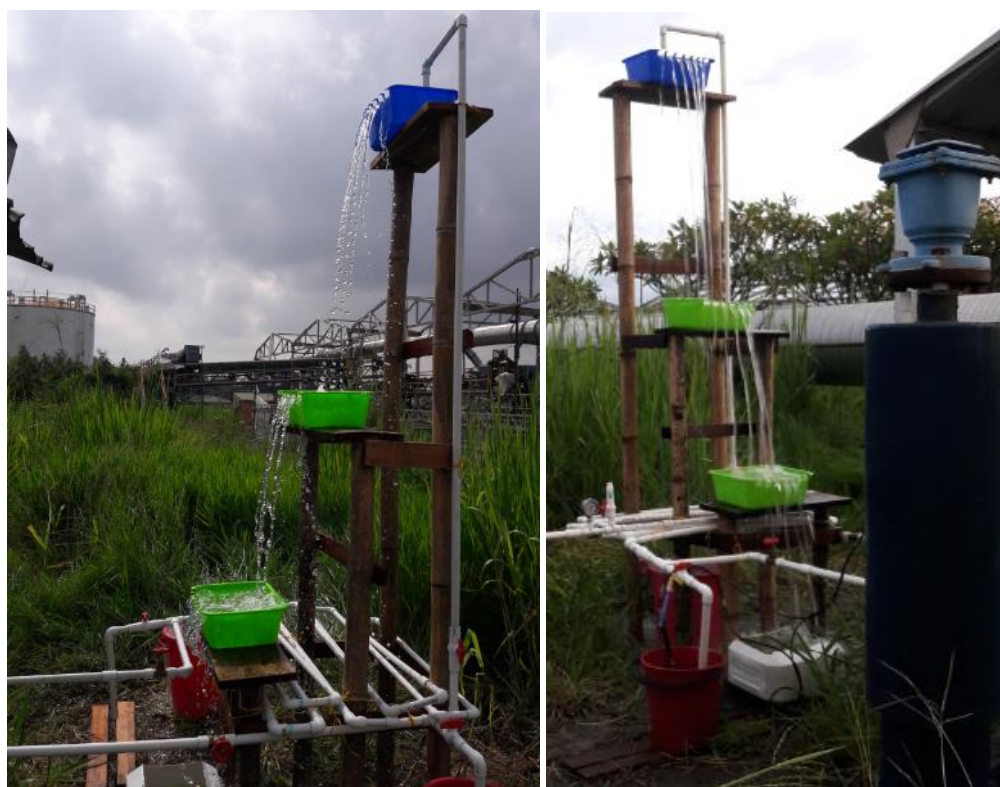
Figura 14. Construcción Aireador de cascadas
