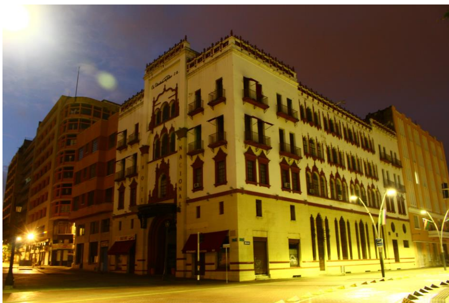
Antiguo edificio de la colombiana de tabaco boulevard del rio Cali Fotografía digital capturada en modo manual 2017
