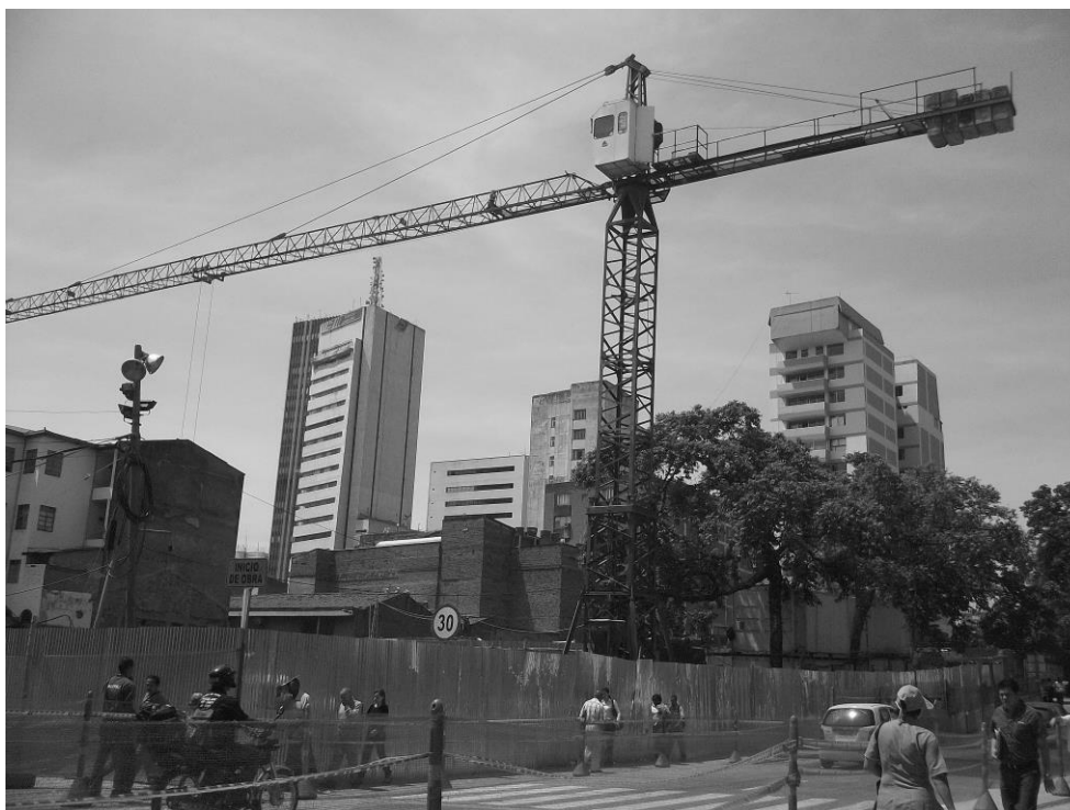
Construcción del sótano del actual edificio del banco de Bogotá boulevard del río Cali Fotografía digital capturada con efecto blanco y negro 2012
