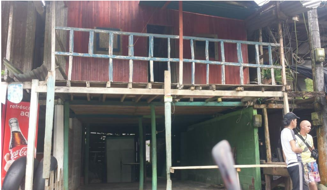
Se evidencia la falta de señalización de los alojamientos
