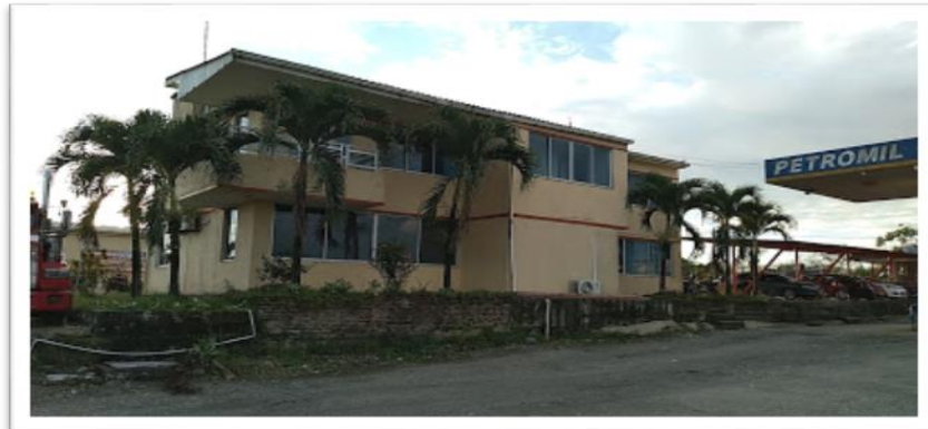
Figura 5. Infraestructura empresa transportes Línea Buenaventura S.A.
