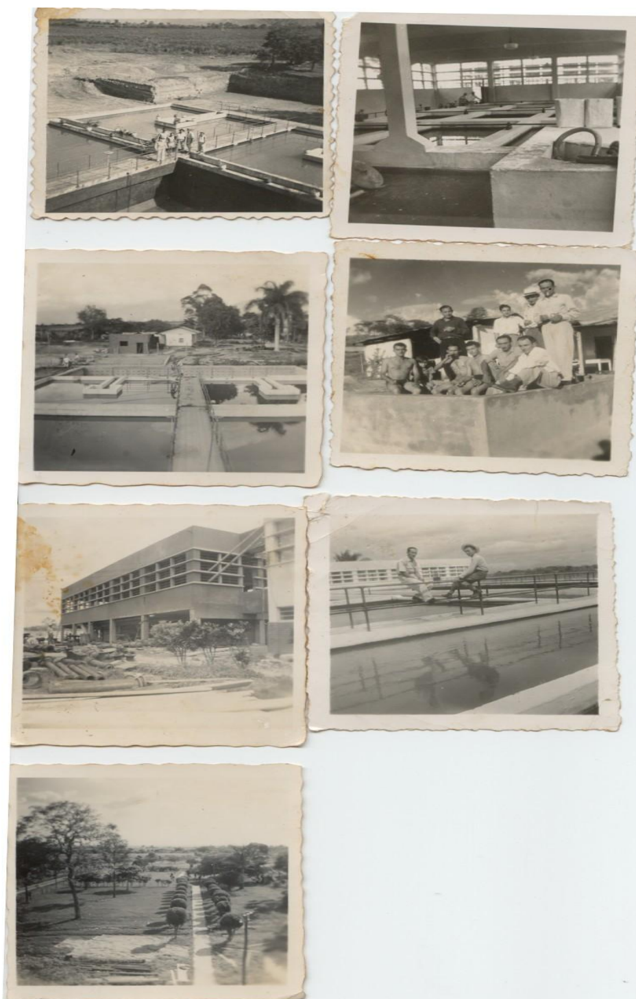
Fuente: Departamento de gestión Social – Acuaviva S.A. E.S.P. Fotografía 2: Planta de Potabilización en construcción
