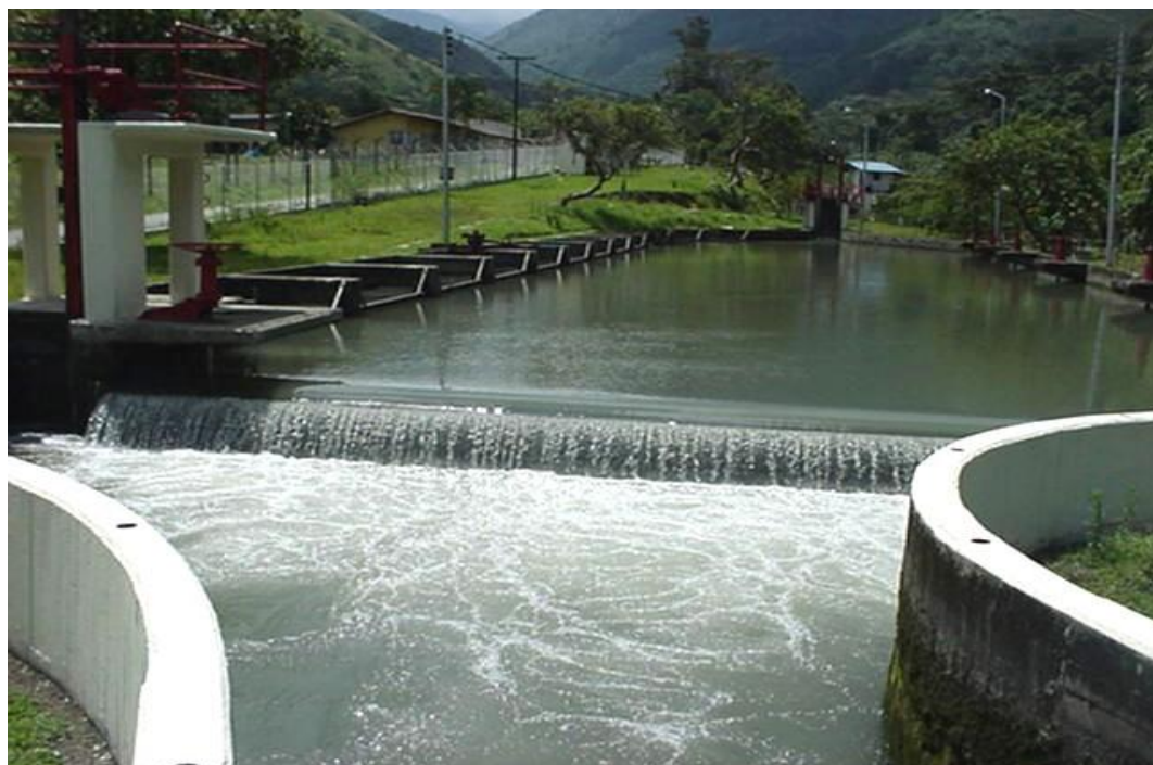
Fuente: Departamento de gestión Social – Acuaviva S.A. E.S.P. Fotografía 7. Bocatoma – Río Nima.
