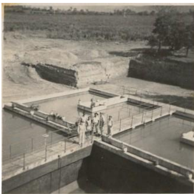
Fuente: Departamento de gestión Social – Acuaviva S.A. E.S.P. Fotografía 3. Planta de Potabilización en construcción
