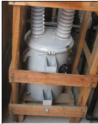
Figura 12. Transformador piloto Rymel 92 .
