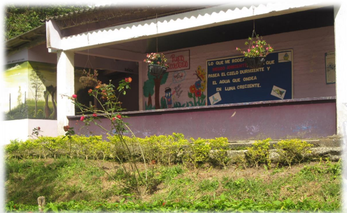
Imagen 7. Fachada del Colegio Técnico Agropecuario Juan Salvador Gaviota
