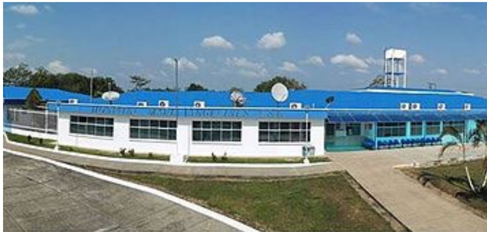
Ilustración 18 Hospital María Angelines Img.Google.com
