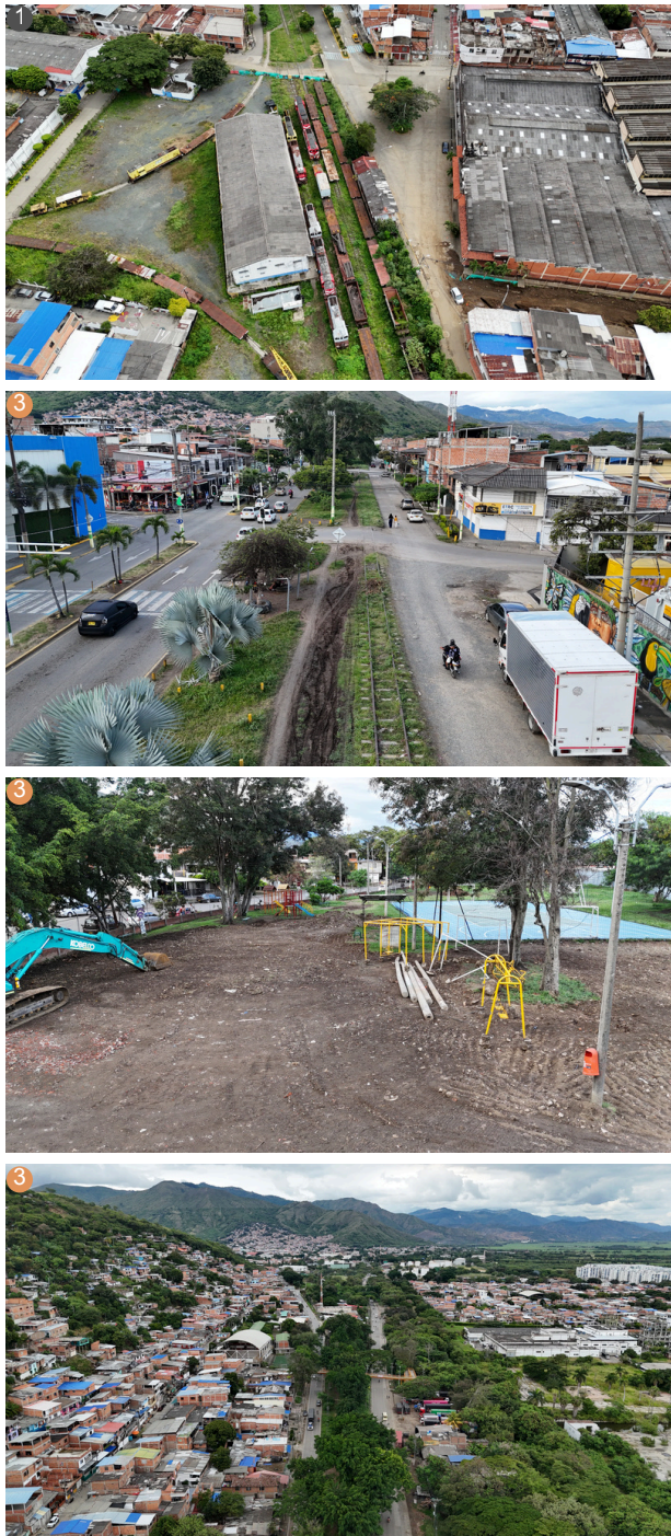
Figura 28. Registro fotográfico del área de intervención
