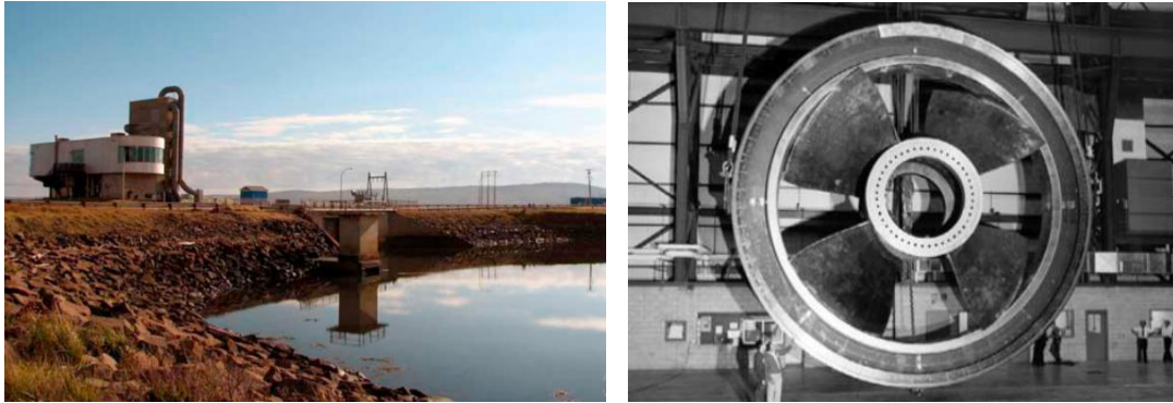
Figura 8. Presa mareomotriz Annapolis, Canadá y Turbina Straflo. Tomado de Neto et al., 2011
