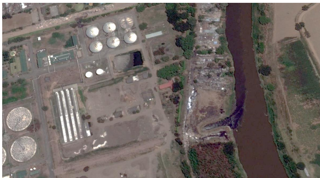
Figura 10. El efluente de la primera fase de la PTAR
