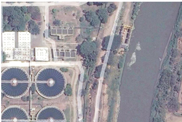
Figura 8. Contaminación del rio cerca a la bocatoma de la planta de Puerto Mallarino.
