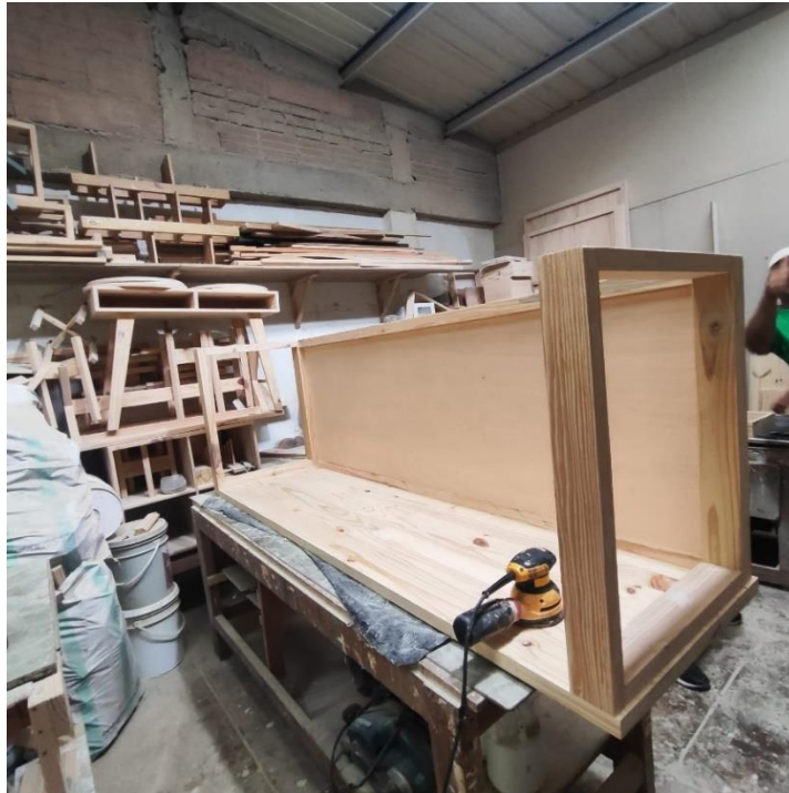
Ilustración 9. Área de resane y lijado. Ecodeco(fotografía) Muñoz A (2025)
