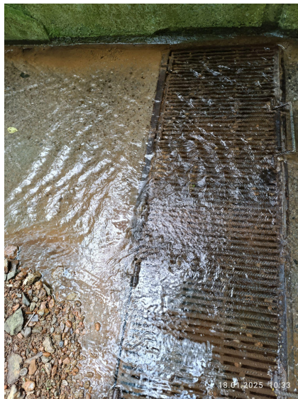
Figura 17. Rejillas medias del acueducto. Fuente: Autor.
