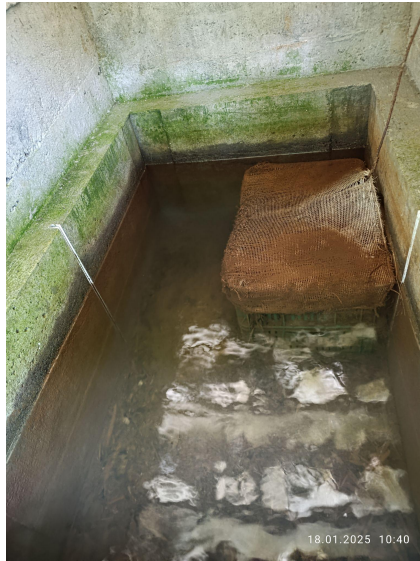
Figura 18. Desarenador del acueducto. Fuente: Autor.
