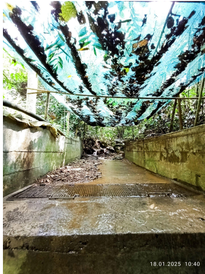
Figura 16. Bocatoma del acueducto. Fuente: Autor.
