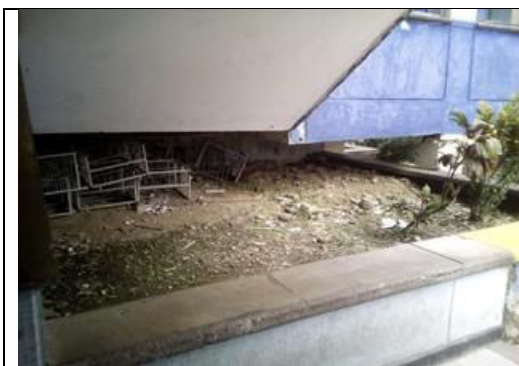
Imagen1: Espacio recuperable, bajo las escaleras del primer bloque. I.E Simón Bolívar
