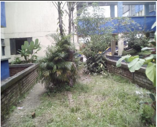
Imagen 8: Zonas verdes sin mantenimiento
