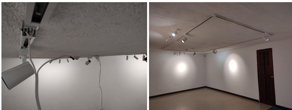
Fotografías del archivo personal de la conexión eléctrica y el montaje final del sistema de iluminación.
