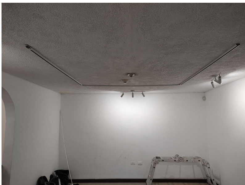
Fotografías del archivo personal de la primera etapa de la instalación del sistema de iluminación.
