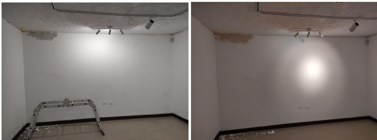
Fotografías del archivo personal de la reparación por humedad en la sala de exposición.
