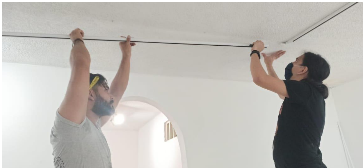
Fotografía realizada por Angélica Narváez del proceso de instalación del sistema de iluminación.
