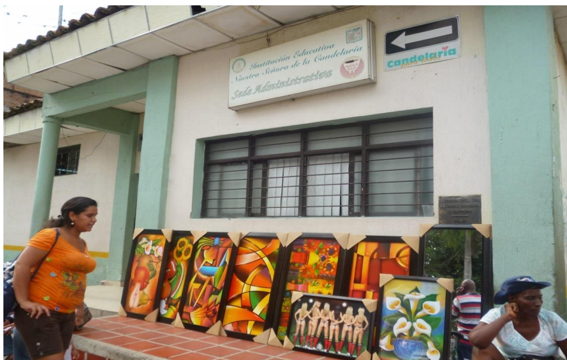
Figura 13. Sede principal de la Institución Nuestra Señora de la Candelaria donde se ubica la parte administrativa. (Sep 4 de 2012 Fuente propia)
