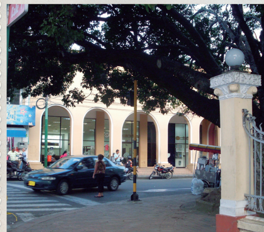
Edificio Los Portales, actual oficina del Banco AV Villas, 2011 Toma desde el Parque José María Cabal.
