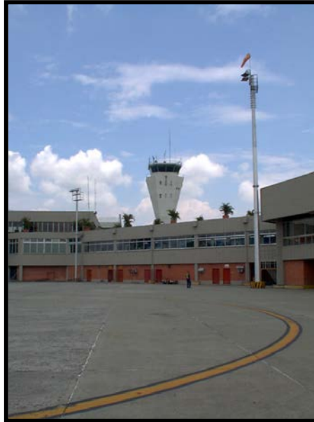
Figura 14. Foto aeródromo Aeronáutica Civil, Regional Valle.
