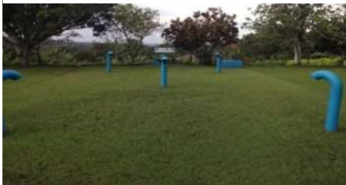
Fotografía 13. Tanque de almacenamiento
