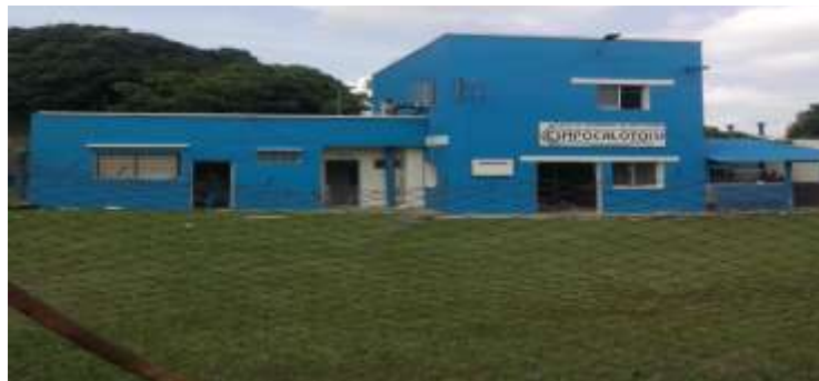
Fotografía 1. Fachada Principal de la Planta de Tratamiento de Agua Potable, Empresa de Servicios Públicos EMPOCALOTO E.S.P
