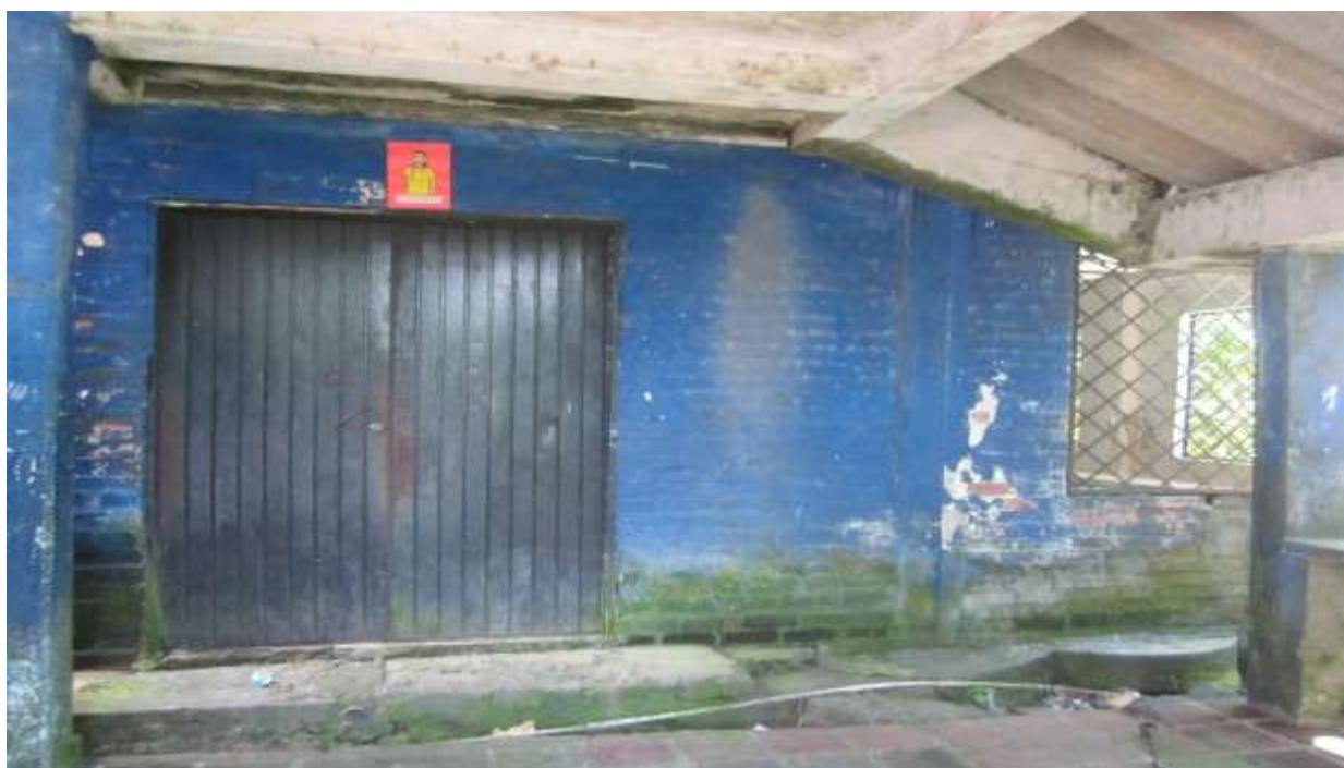
Foto tomada por equipo investigador. Vista exterior del Restaurante escolar
