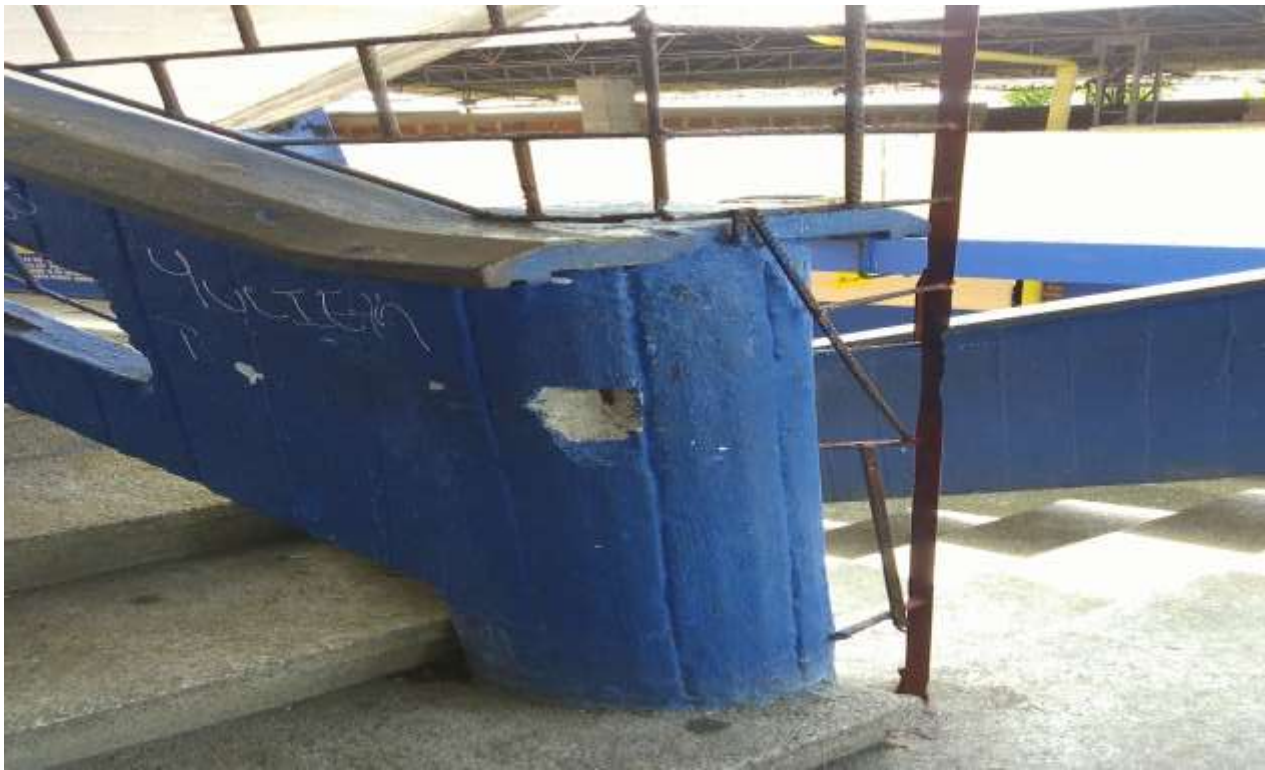
Foto tomada por equipo investigador. Pasillo hacia los salones segundo piso
