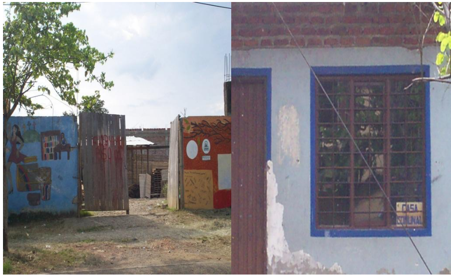
"La caseta" (calle 23 entre carrera 47 y 48)
