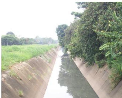
Canal CVC Sur que atraviesa el barrio paralelo a la calle 25, límite oriental con la Autopista Simón Bolívar
