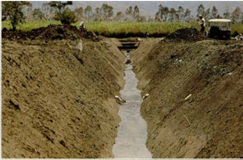
Obras de adecuación en la planicie inundable.
