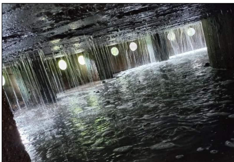
Figura 34. Soporte del relleno del filtro percolador
