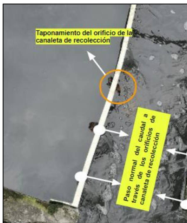
Figura 100. Recolección ineficiente del efluente del sedimentador final
