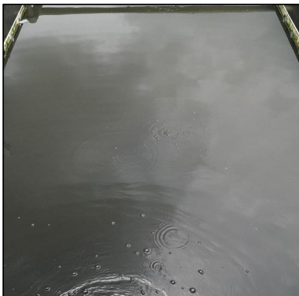
Figura 77. Liberación de burbujas de biogás por la zona de recolección del efluente
