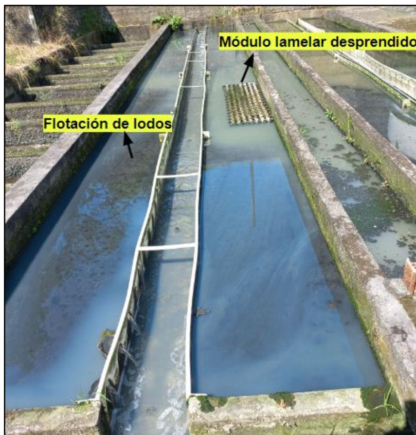
Figura 99. Falencias encontradas sedimentador final
