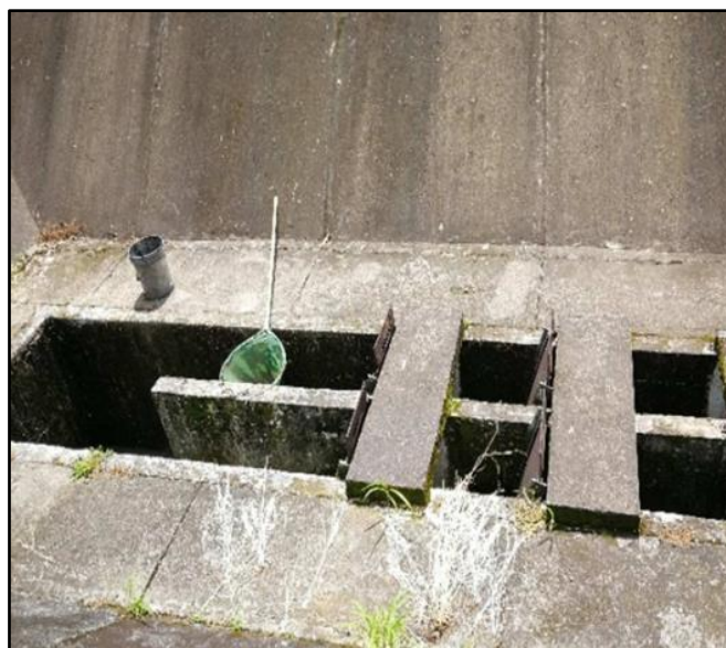
Figura 51. Herramienta empleada para el retiro de residuos sólidos
