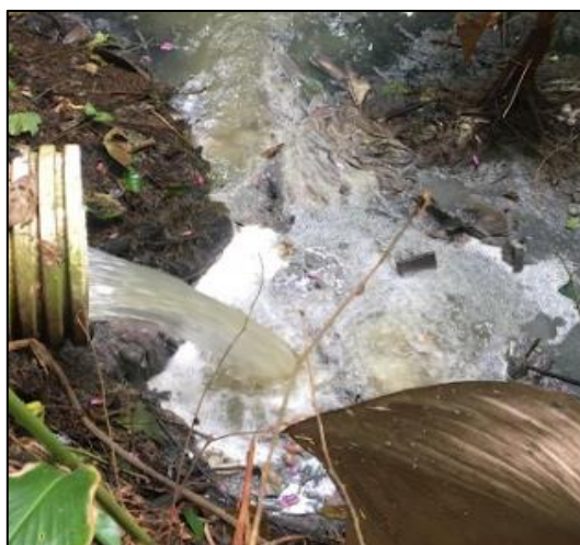
Figura 47. Punto de descarga de agua residual de exceso a la fuente hídrica receptora
