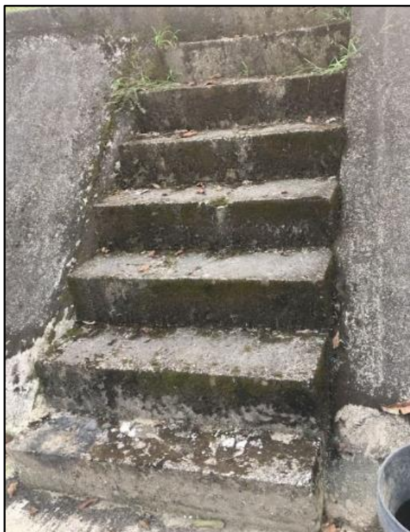
Figura 54. Estado actual de las escaleras de acceso al sistema preliminar
