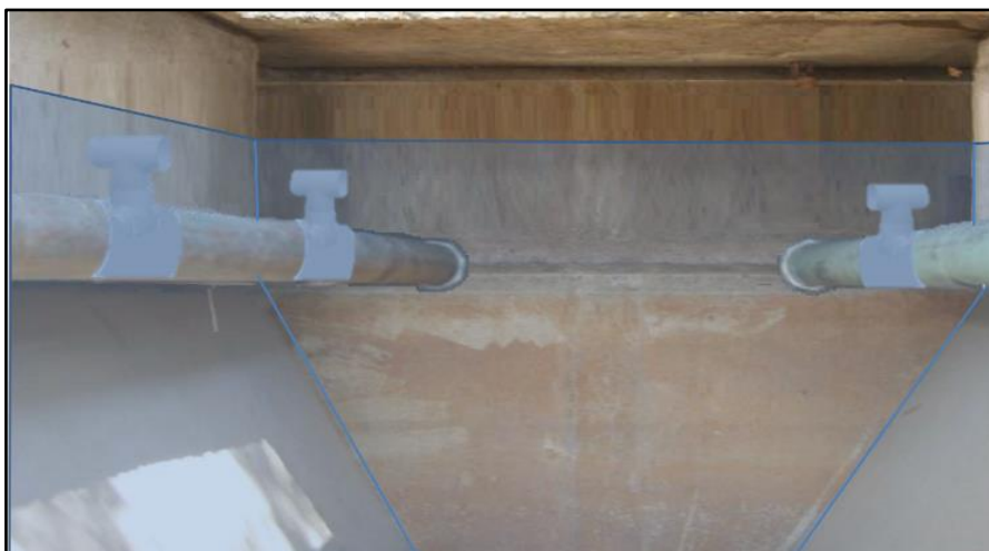
Figura 84. Recolección del efluente por medio de tees sumergidas Fuente: Rodríguez (2022)
