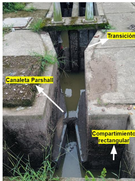
Figura 20. Transición hacia Canaleta Parshall y compartimiento integración del agua residual
