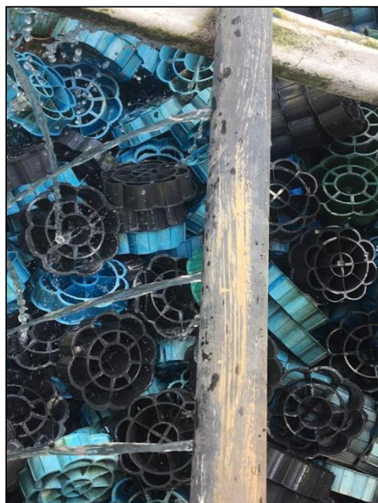
Figura 33. Medio filtrante del filtro percolador
