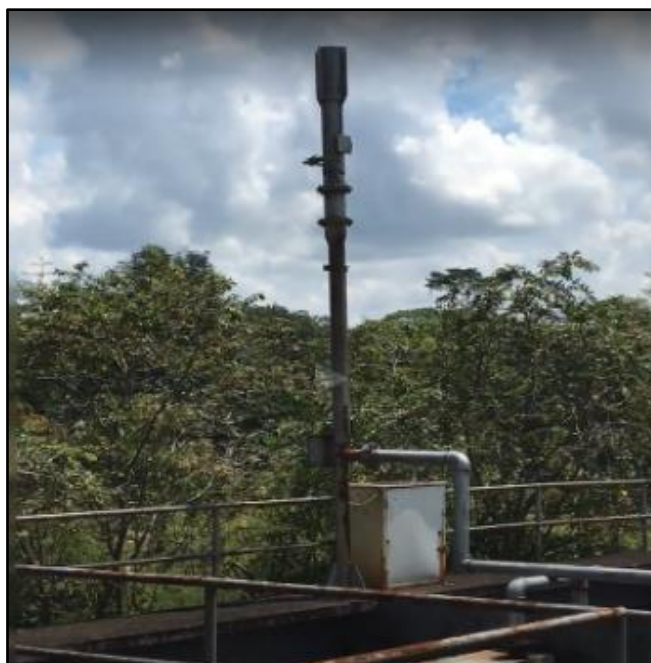
Figura 78. Tea de quemado sin funcionamiento
