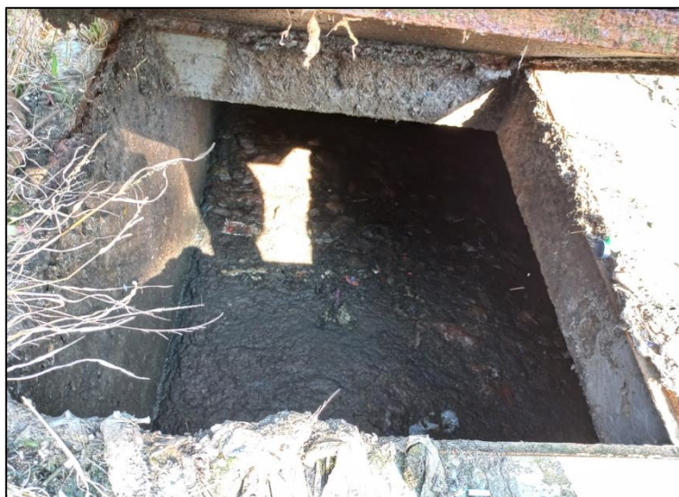
Figura 25. Interior del tanque homogeneizador
