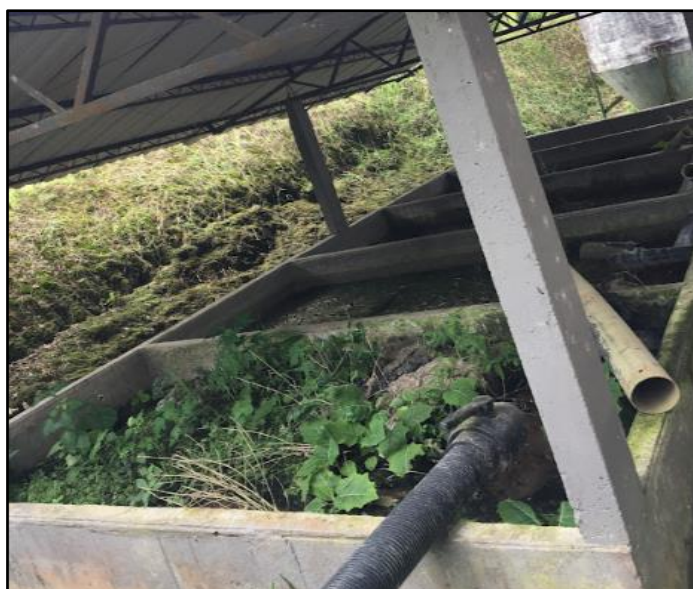
Figura 104. Lecho de secado de la PTAR
