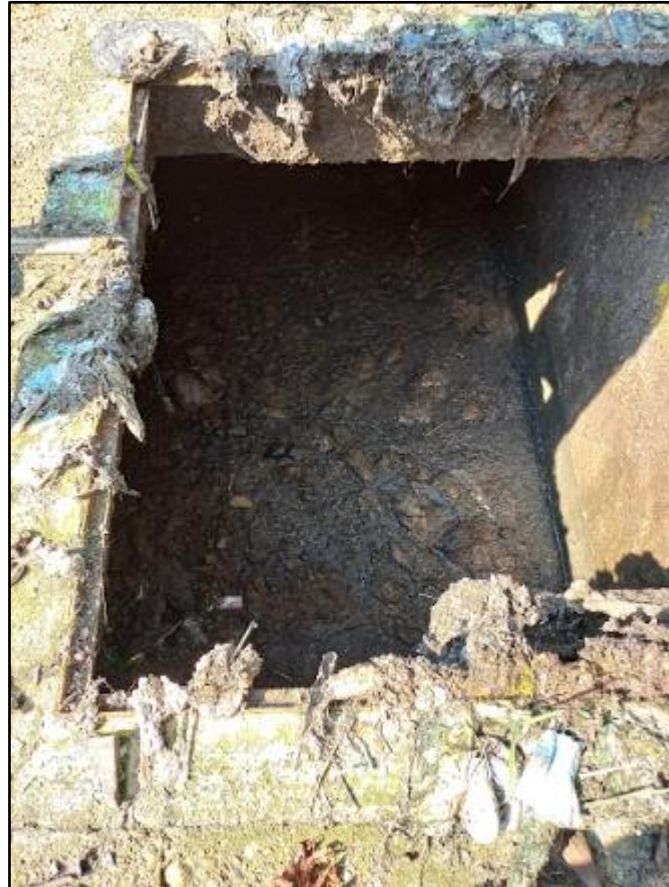
Figura 68. Interior del tanque homogeneizador
