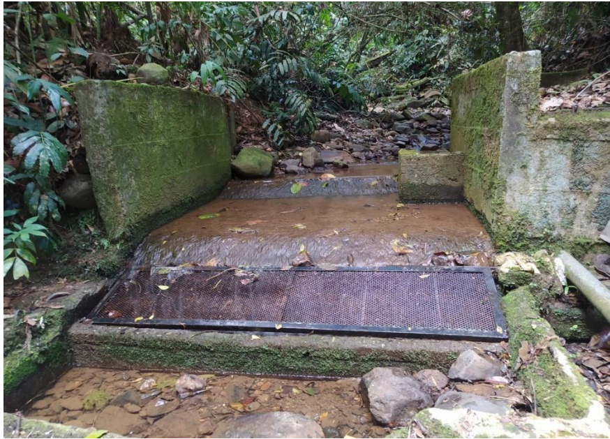
Figura 6 Bocatoma Los Arrieros.
