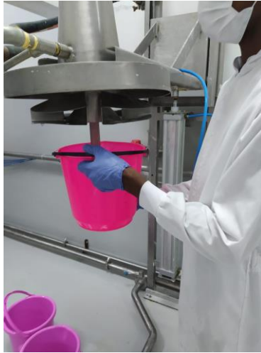
Figura 15: Aforo volumétrico en el CIP
