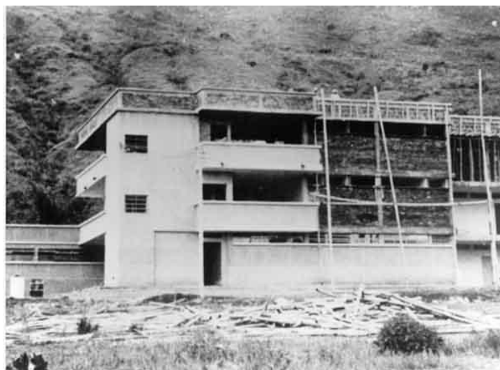
Imagen 21 Construcción del Colegio Mayor de Yumbo 1959 168
