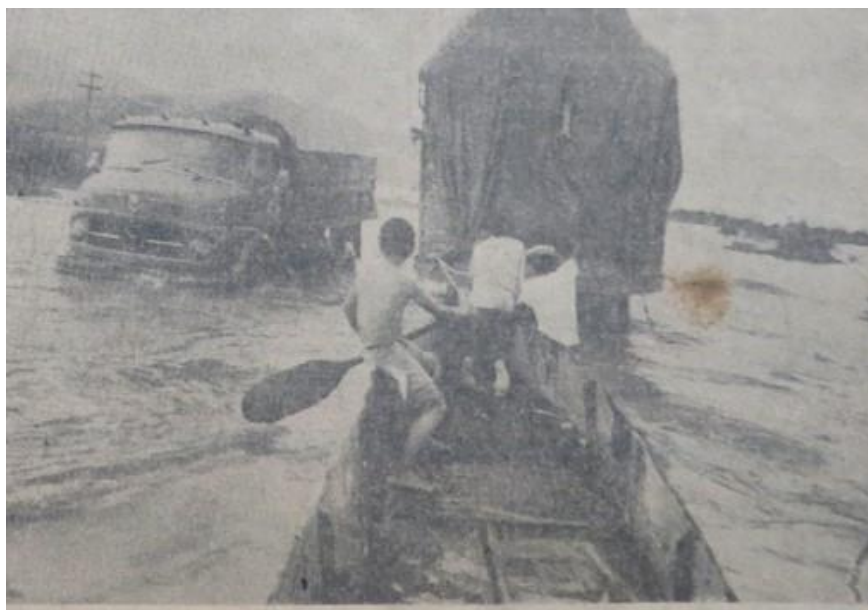
Imagen 11 Inundación de la autopista Cal-Yumbo 1971 111
