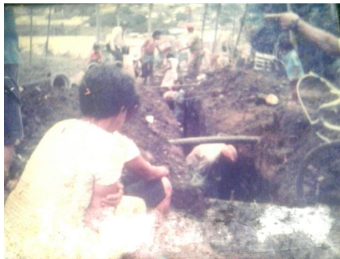
Imagen 20 Trabajo Comunitario Alcantarillado Barrio las Cruces 1987. 158
