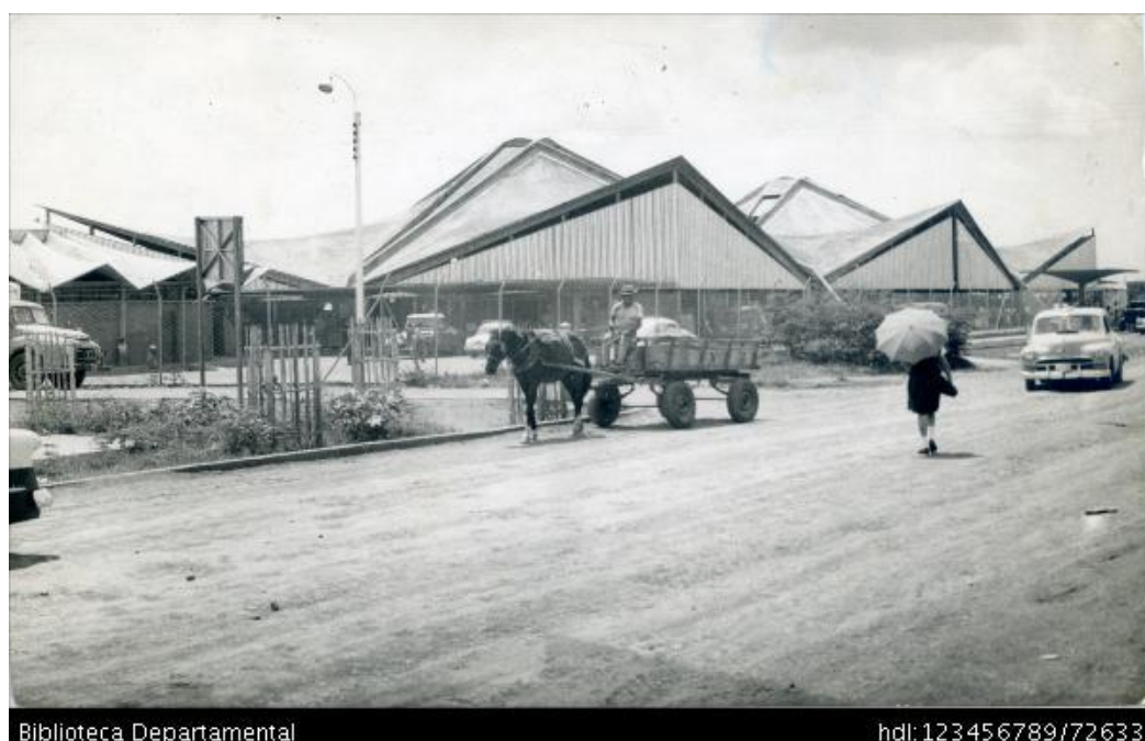
Imagen 22. Aspecto exterior de la galería Santa Elena por la actual calle 23 (1974)
