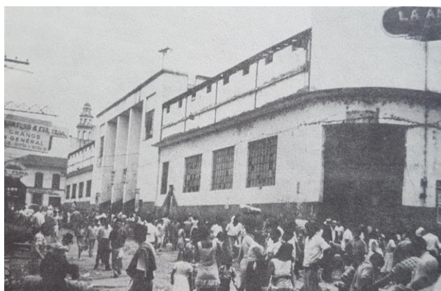
Imagen 18. Antigua Galería Central (c. 1970) “Aspecto parcial de la antigua Galería Central, en proceso de demolición”
