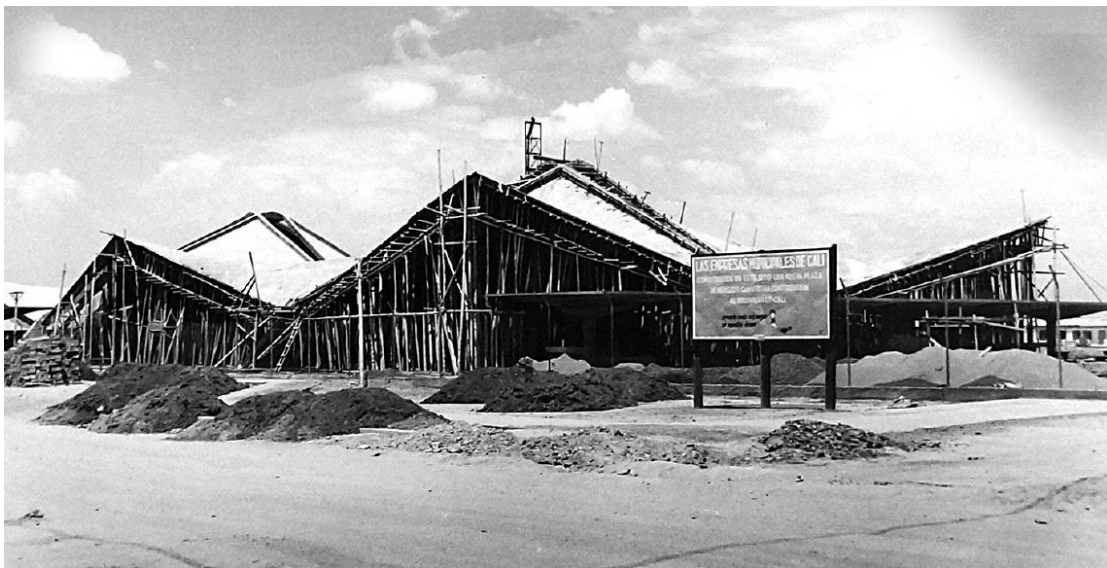
Imagen 20. Construcción de la galería Santa Elena (c. 1962)
