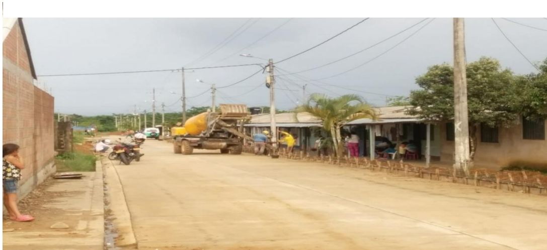
Figura 4 Viviendas La Gloria Etapa III – Proceso de pavimentación de la vía principal de la Urbanización.
