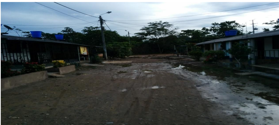
Figura 7 Calles en mal estado en La Gloria etapa I – Vía principal de la Etapa I sin pavimentar.
