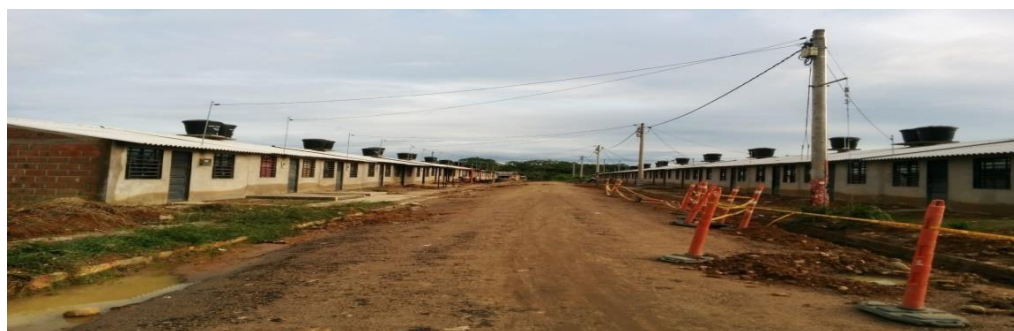
Figura 3 Viviendas de interés social- Etapa III- Construcción de alcantarillado y acueducto en la etapa III- Viviendas en obra negra.
