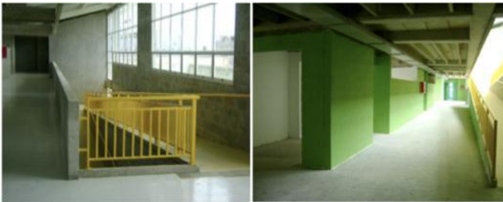
CIRCULACIONES Y RAMPA
