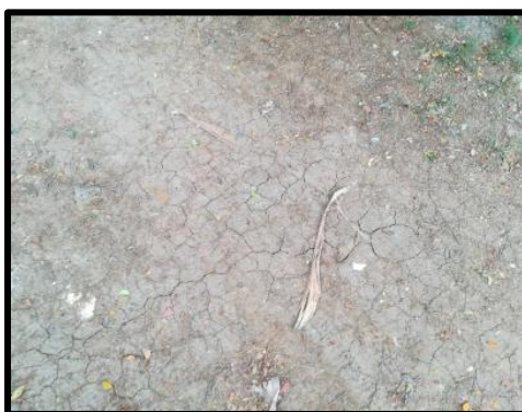
Figura 135. Suelo con presencia de piel de cocodrilo. Elaboración propia
