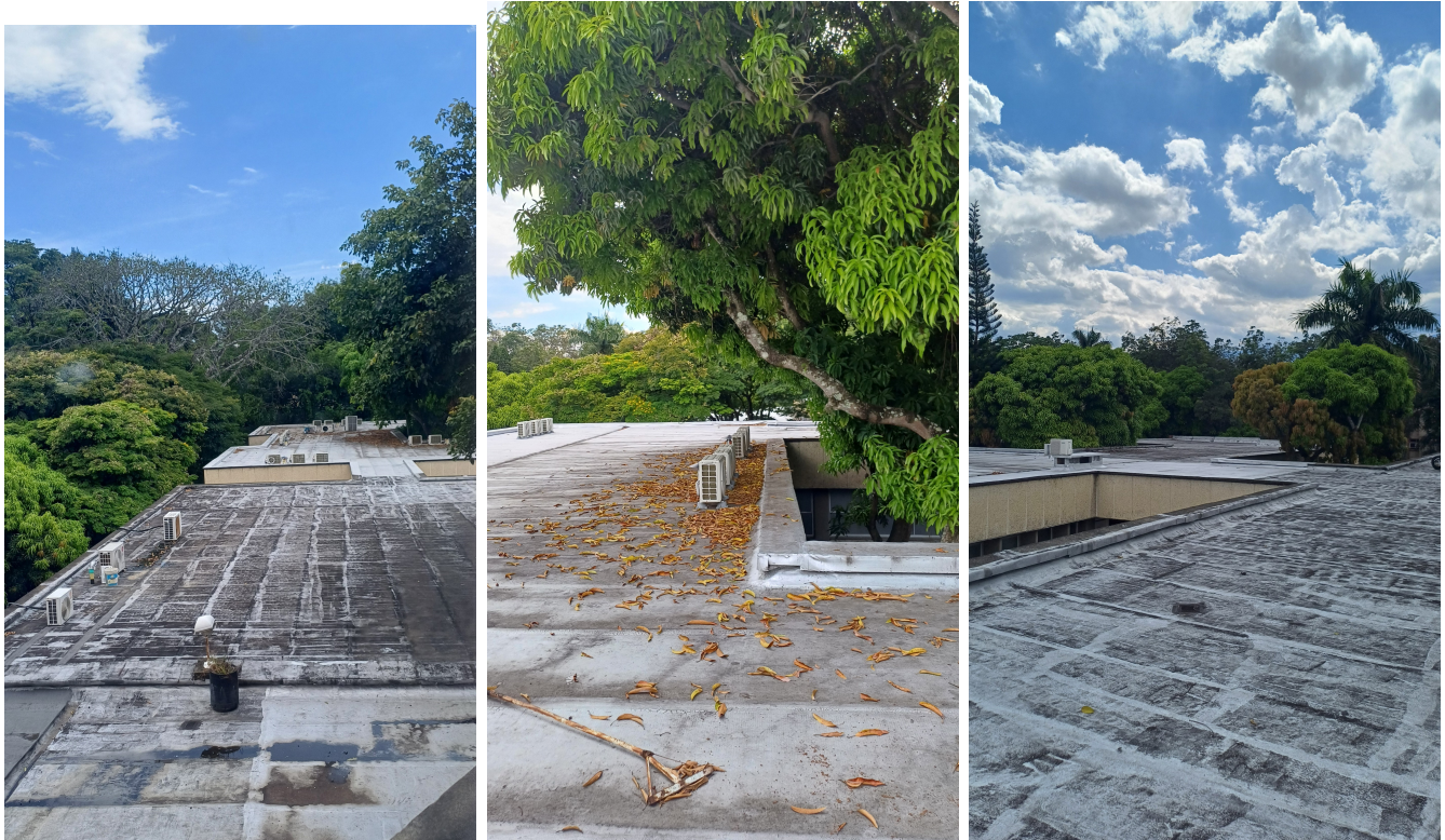
Figura 1.3: Terraza de la Escuela de Ingeniería. Propia autoría.
