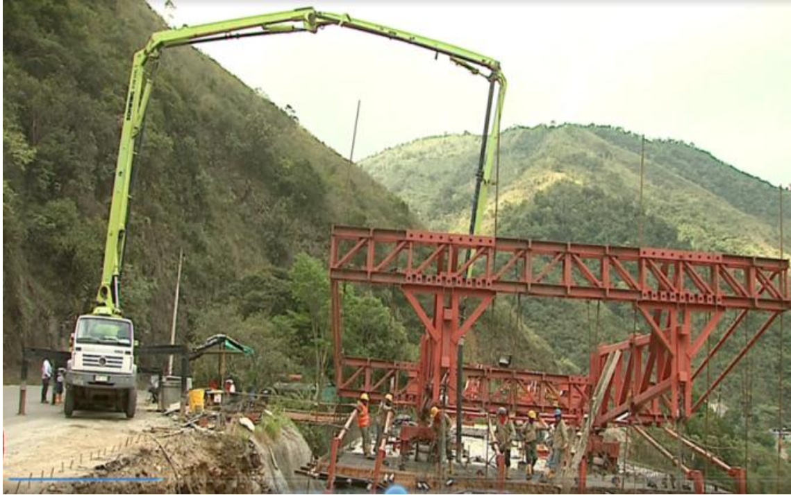
Figura 8: Construcción de la doble calzada entre Cisneros y Loboguerrero
