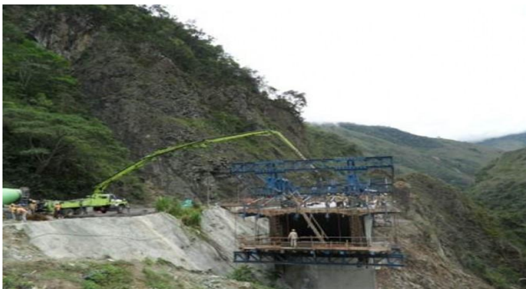
Figura 6: Construcción de la doble calzada entre Cisneros y Loboguerrero (Punto parcialmente construido)
