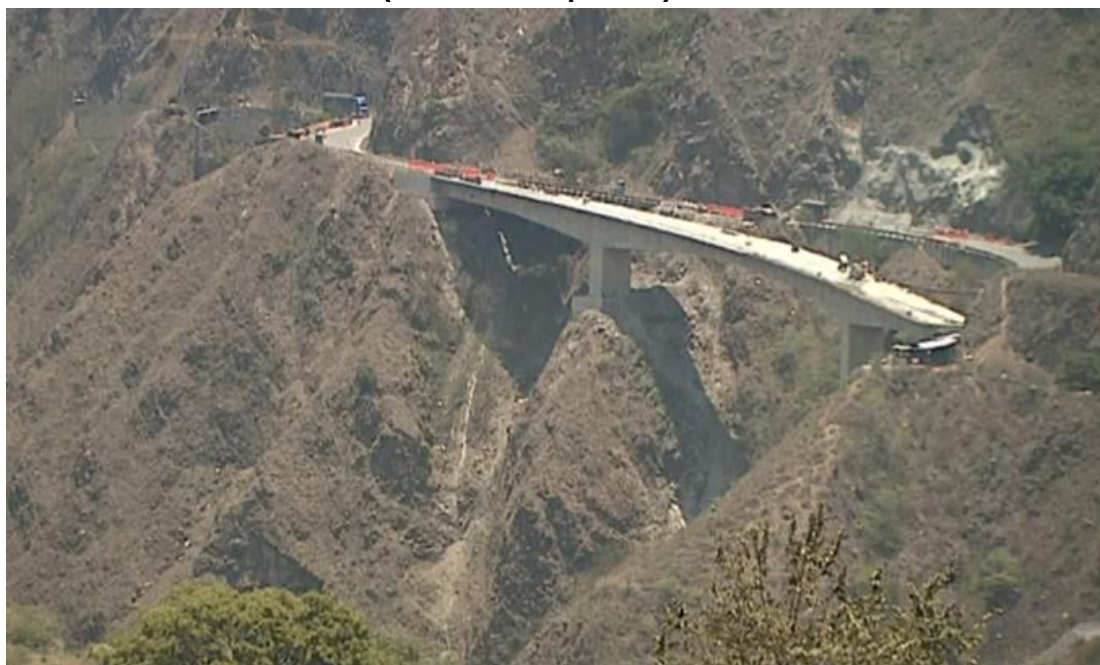
Figura 7: Construcción de la doble calzada entre Cisneros y Loboguerrero (Finalización puente)
