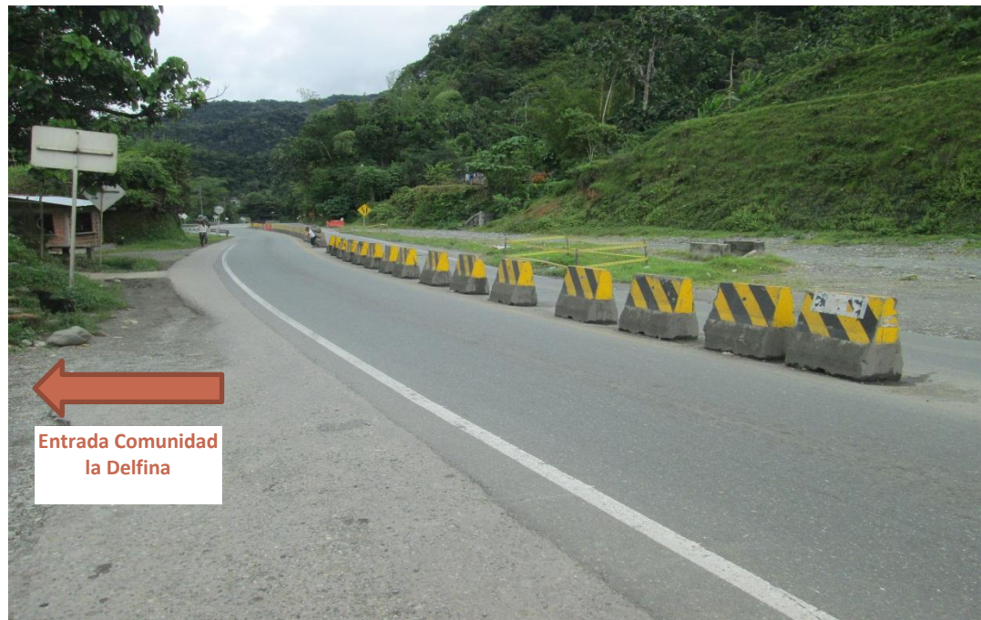
Figura 5: Construcción de la doble calzada al paso de la Comunidad indígena Nasa Kiwe de la Delfina
