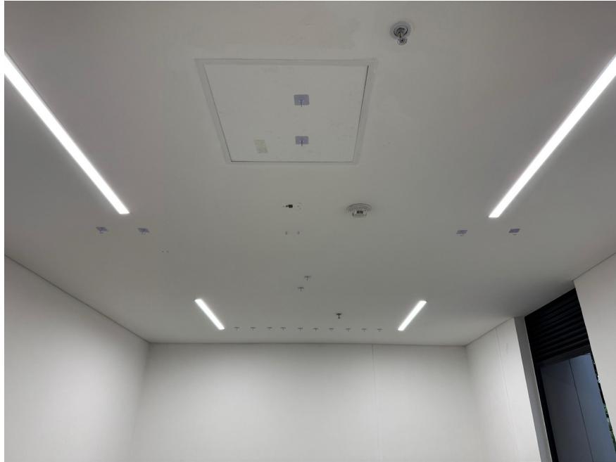
Figura 83. Ganchos instalados en el techo para soporte de estructuras circulares.
