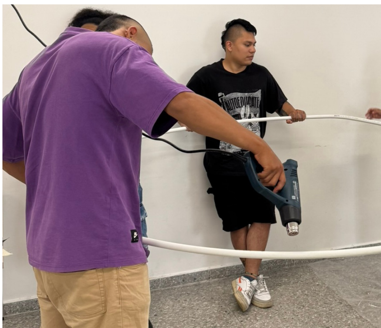
Figura 77. Aplicación de calor con pistola de calor para dar forma al tubo de PVC.
