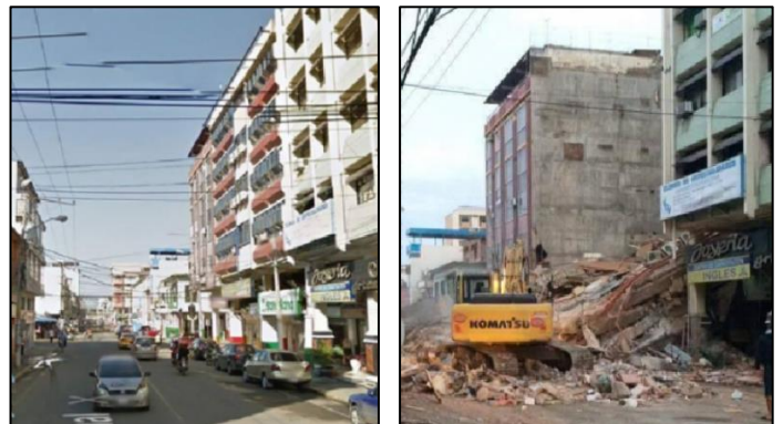
Figura 4: edificación antes y después del sismo de Ecuador del 2016.
