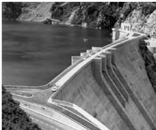
Figura 2.2 Central hidroeléctrica de agua embalsada [14]
