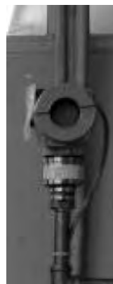
Figura 3.12 Transmisor inteligente de presión LD 291
