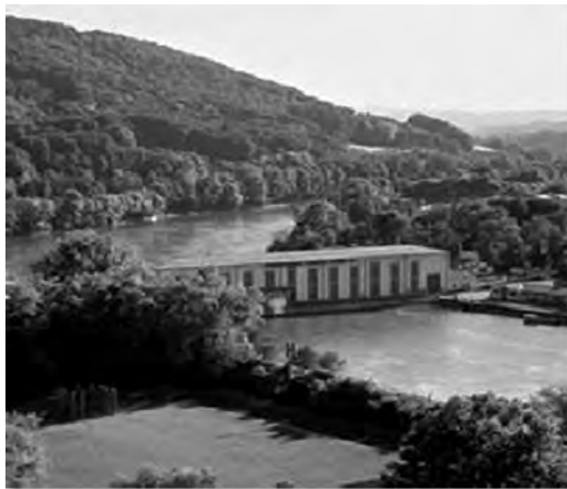
Figura 2.1 Central hidroeléctrica de aguas fluyentes [14]
