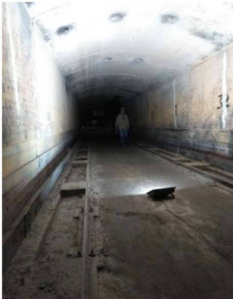
Ilustración 13. Interior Horno Túnel. Fuente Autor
