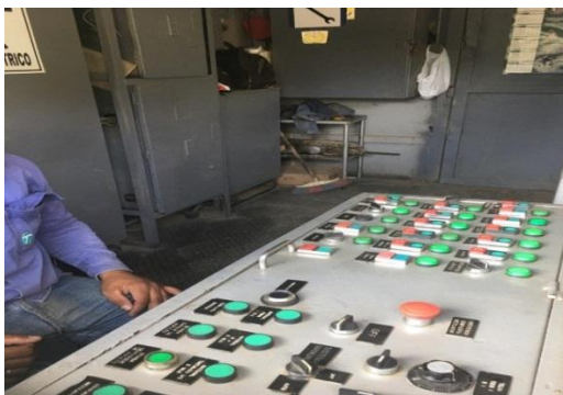
Figura 12 Operador de plantas de asfalto.
