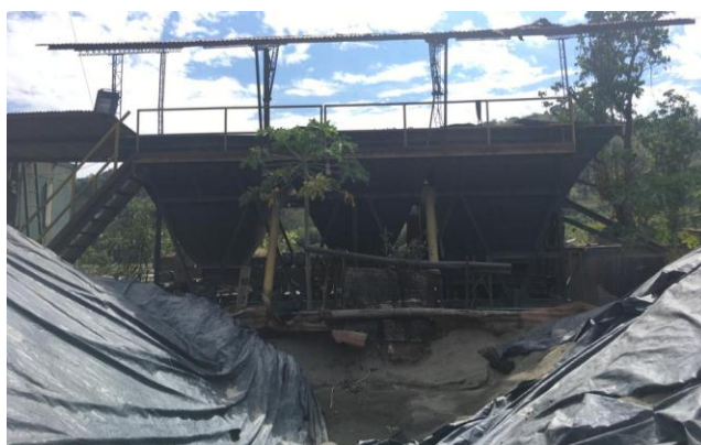
Figura 26 Visual general de la planta de asfalto.
