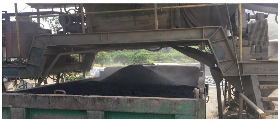
Figura 14 Producto terminado, mezcla asfáltica y transporte a sitio de aplicación.
