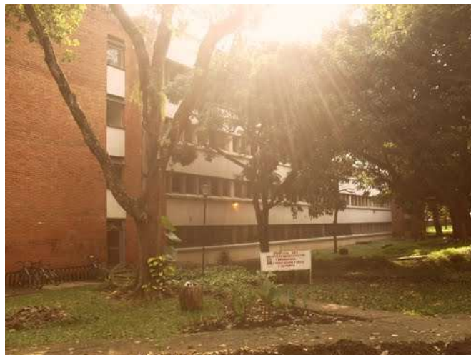
Figura: Edificio 381 Univalle.
