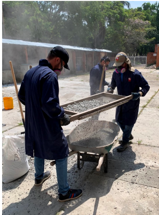
Figura 13. Tamizado del RCD Fuente. Propia.
