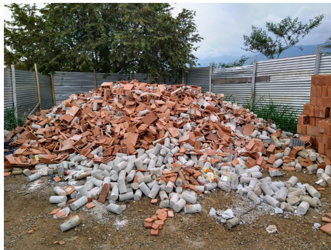
Figura 10. Punto limpio (escombrera) de la constructora, donde se disponen normalmente los RCD limpios, incluidos los cilindros testigos ensayados. Fuente. Propia
