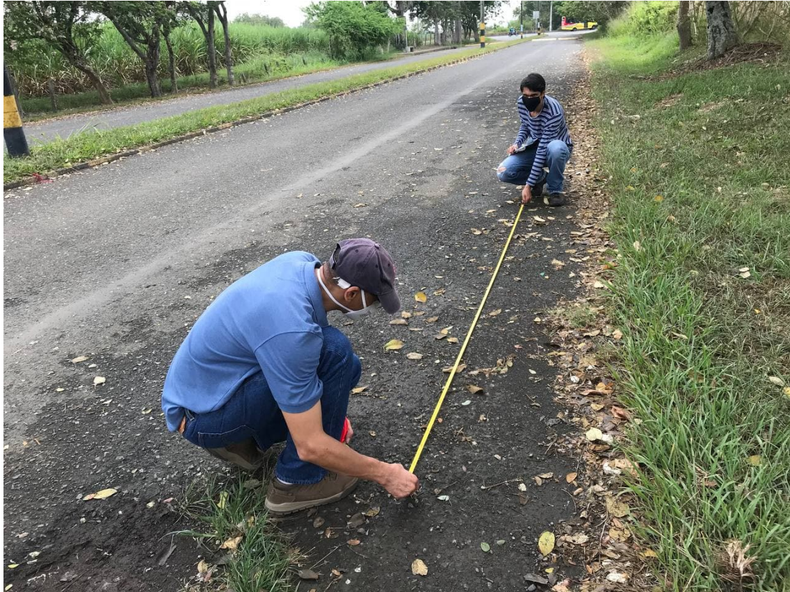
Figura 26: Procedimiento de inspección manual en campo.
