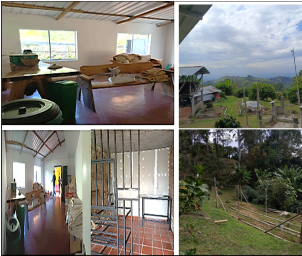
Figura 26. Espacios de adecuación y construcción de la Finca Villa Daniela.
