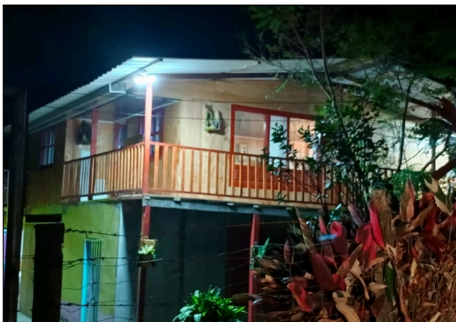
Figura 10. Infraestructura exterior e interior de la cabaña “soul by Tabi”.
