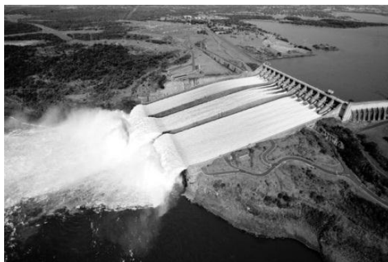
Figura 2 Central hidroeléctrica de Itaipú, frontera entre Brasil y Paraguay [7].
