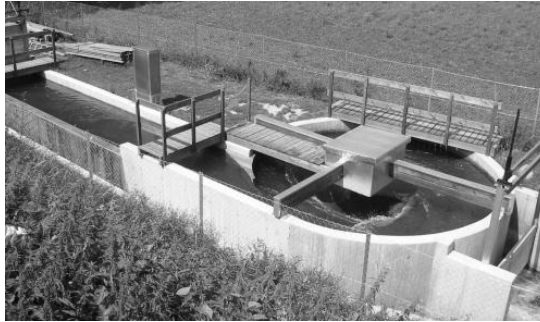
Figura 7 Prototipo de la PHGV en operación [12].
