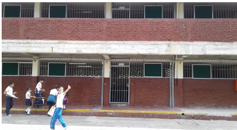
Figura 8. Patio Central y Salones de Clase – Bloque 2
