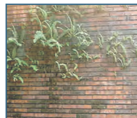
36. Fuente: Curso patología de la construcción.
