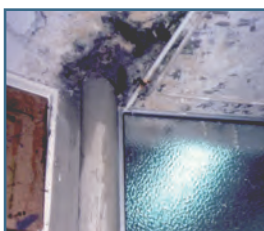
47. Fuente: Curso patología de la construcción
