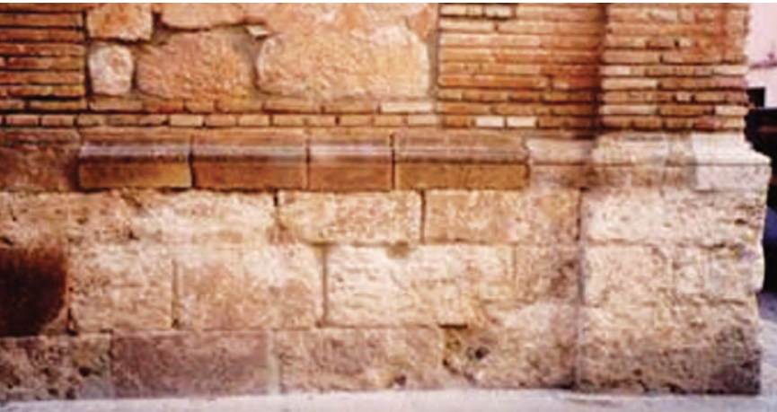
Pátina de suciedad en bloques de calizas
