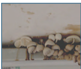
37. Fuente: Curso patología de la construcción.
