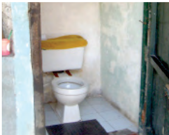
Decoloración de muros
