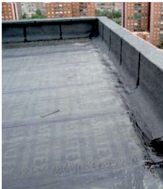
Figura 5.21 Colocación de la tela asfáltica
