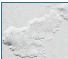
42. Fuente: Curso patología de la construcción.
